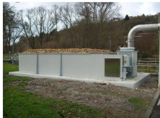
Abb. 2 und 3: Standard Biofilter
